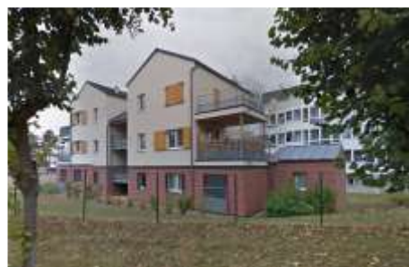
Nouveaux logements sociaux, résidence Albert Calmette
